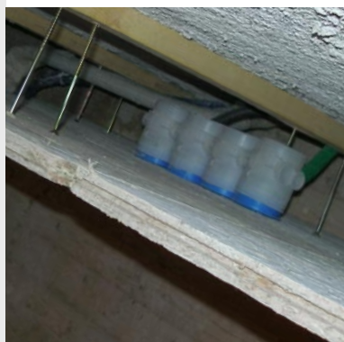
Les boîtiers, les gaines électriques et les tuyaux sanitaires sont noyés dans les doublages.
