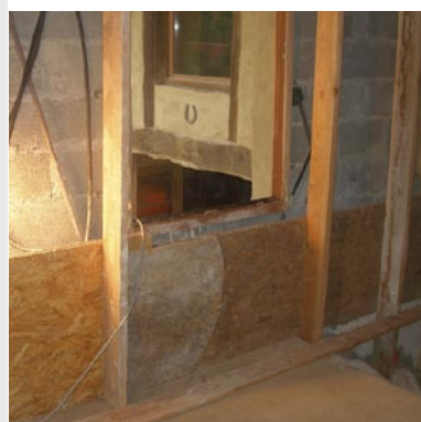
Le coffrage est ici maintenu par une structure extérieure, fixée au sol et aux solives du plafond.
